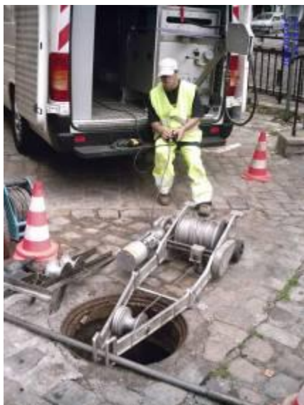
Chemisage continu du réseau
