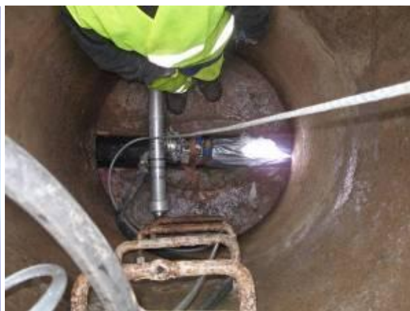
Mise en place dans un regard
