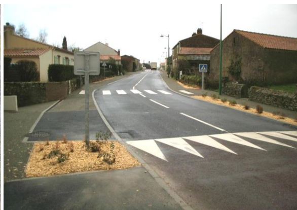
Lors des travaux de voirie les tampons ont été oubliés
