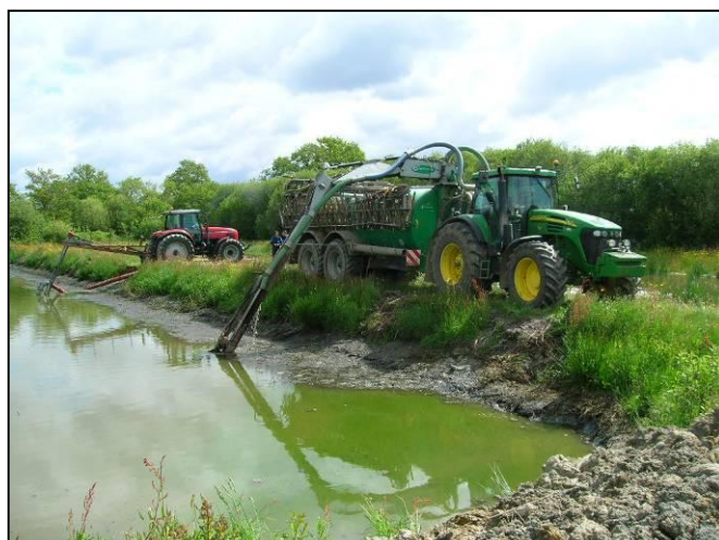
Pompage des eaux surnageantes
