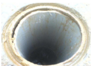
La tête de tabouret appuie sur la cheminée et aire lavage des véhicules non couvert.
