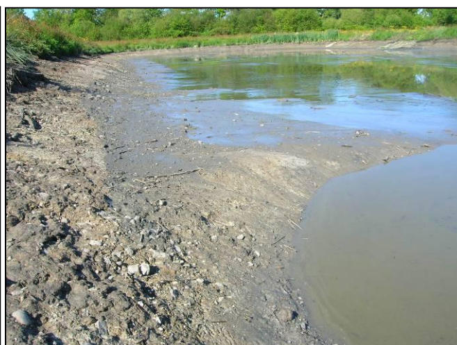
lagune en fin de curage
