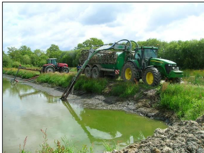
Pompage des eaux surnageantes
