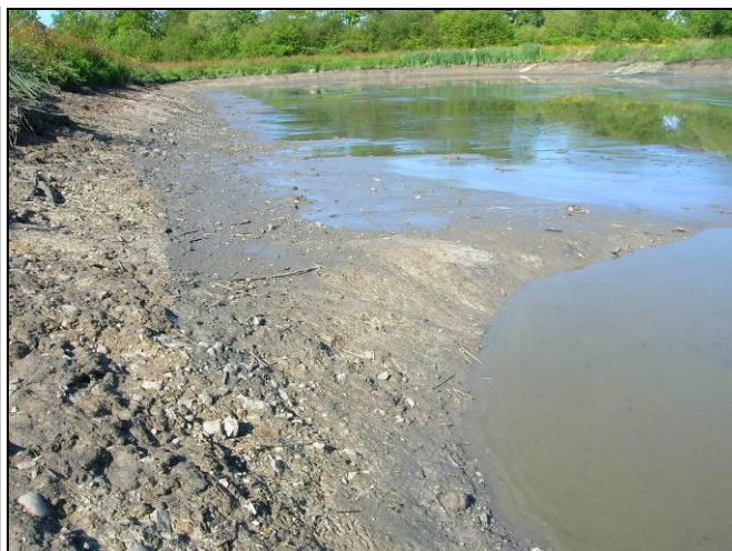
lagune en fin de curage
