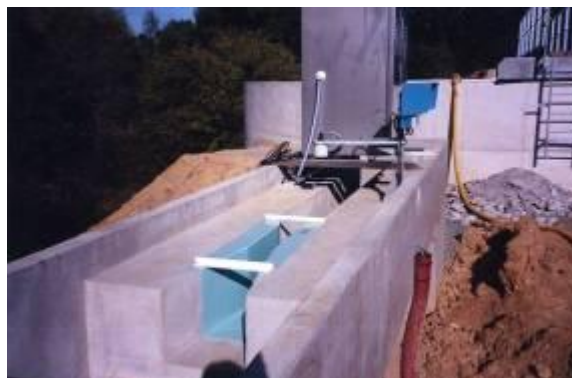
Débitmètre à ultrason
