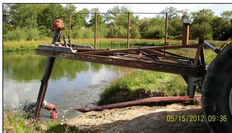
Pompage de la phase liquide
