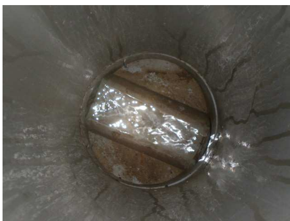
FIGURE 12 : APPORTS D'EAUX CLAIRES EN PROVENANCE D'UN BRANCHEMENT RUE DE MALNOË
