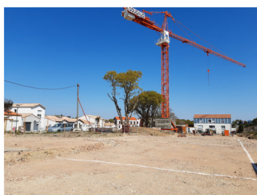
Travaux Pornic - mai 2021 (CISN Résidences Locatives)
