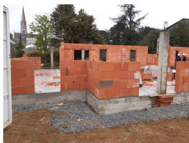
Travaux Sainte-Pazanne - mai 2021 (CISN Résidences Locatives)
